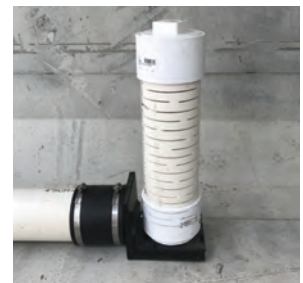
Drain Down Module
